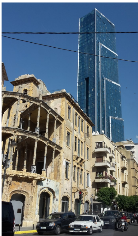
Beirut ein Vierteljahrhundert nach der Beendigung des Bürgerkrieges im Libanon: Das „Barakat Gebäude“ lag an der „Grünen Linie“, welche die Stadt im Krieg teilte, und diente Scharfschützen als Stellung. Es sollte Ende der 90er Jahre abgerissen werden, soll nun aber in ein Museum und Kulturzentrum verwandelt werden. 1 Foto: Birte Brugmann, 2016.
